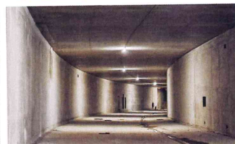
Herstellung der Wände und Decken im Tunnel Emichgasse mit einem Schalwagen.
