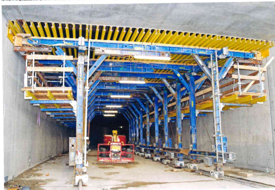
Herstellung der Wände und Decken im Tunnel Emichgasse mit einem Schalwagen.
